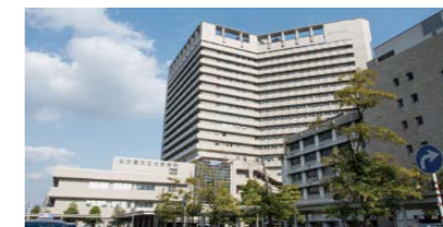
名古屋市立大学病院外観 Nagoya City University Hospital
