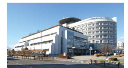
西部医療センター外観 Nagoya City University West Medical Center
