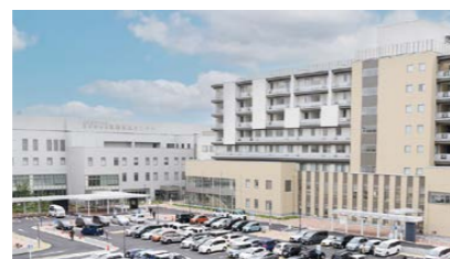
東部医療センター外観 Nagoya City University East Medical Center
