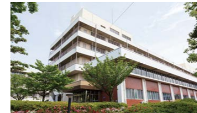
みらい光生病院外観 Nagoya City University Mirai Kousei Hospital
